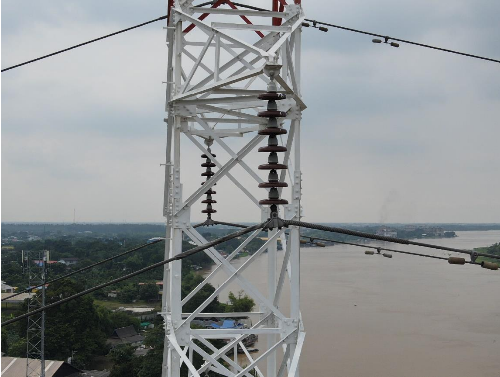
รูปที่ 5 ตัวอย่างภาพลูกถ้วย (Suspension Insulator)
