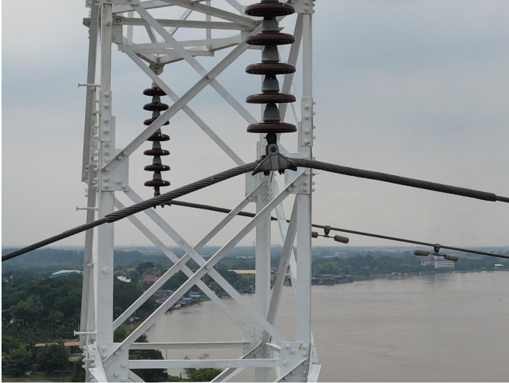
รูปที่ 7 ตัวอย่างภาพแคล้มป์จับสายไฟ
