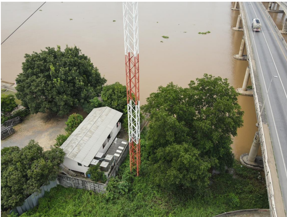
รูปที่ 2 ตัวอย่างภาพโครงสร้างเสา (Tower body)
