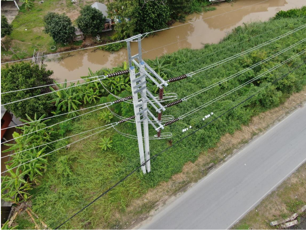
รูปที่ 9 ตัวอย่างภาพรวมของเสาไฟ (Overall view of concrete pole)
