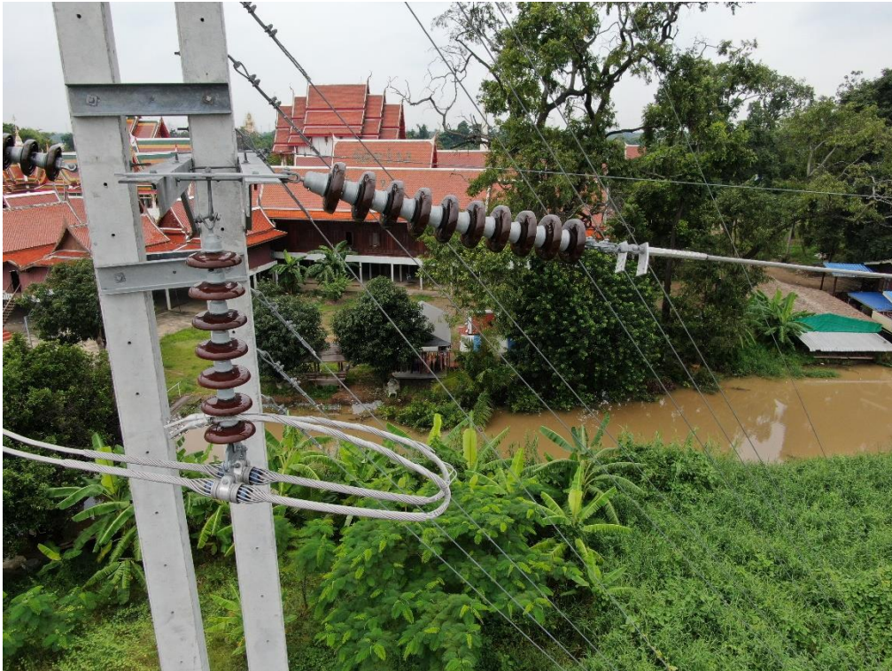
รูปที่ 13 ตัวอย่างภาพลูกถ้วย Insulator
