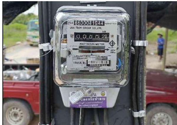
ตัวอย่าง รูปมิเตอร์เครื่องเดิมที่รื้อถอนโดยให้เห็นหมายเลข พีอีเอ. Security Seal และ Marking แสดงสายไฟฟ้าด้านเฟส
