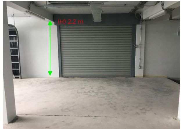
(1) ประตูเลื่อนทางเข้า : ฝั่งด้านใน Cable Room, ความสูงประมาณ 2.2 เมตร
