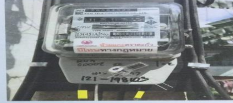
กรณี มิเตอร์ติดตั้ง เฟส C (สีน้ำเงิน)
