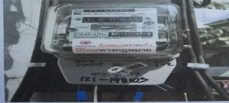
กรณี มิเตอร์ติดตั้ง เฟส C (สีน้ำเงิน)
