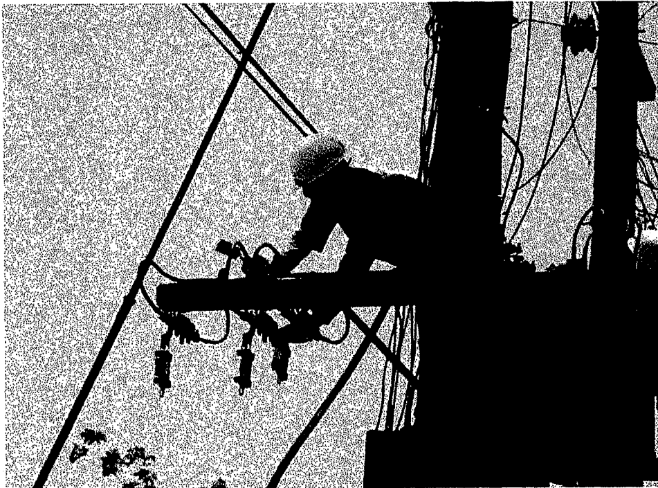
5) ขณะทำความสะอาดหน้าสัมผัส LT-Switch - รูปถ่ายขณะทำความสะอาดหน้าสัมผัส LT-Switch ที่แสดงให้เห็นตัวถังหม้อแปลง
